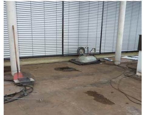
Abbildung 5: Extrembeispiel: Einlagige Bitumenabdichtung auf einem Luxus-Appartementhaus. Schadenseintritt nach 4 Jahren.
