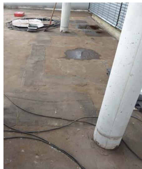
Abbildung 7: "Das Abdichtungssystem ist vollflächig abgeschottet und dadurch nicht wasserunterläufig. Auf eine Eindichtung der Stützen kann somit verzichtet werden" (Meinung der ausführenden Firma).
